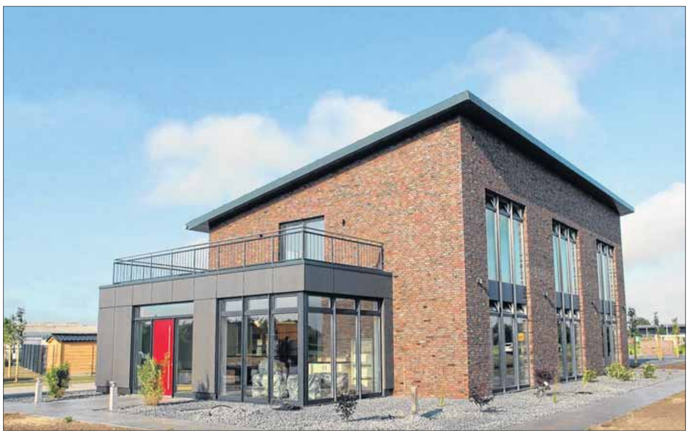
Außenansicht des Büroneubaus der Firma Stahl in Emlichheim. Das Bild oben zeigt das Mitarbeiterteam.
